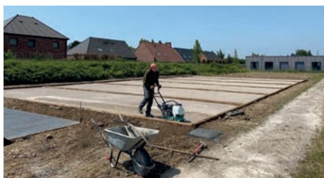
Création des terrains de pétanque
